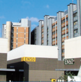
実験棟群とウェスト3号・4号館
