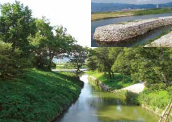
嘉瀬川から多布施川へ水を分ける水利施設である石井樋は、元和年間(1615～1624)に造られ、洪水により破壊されていましたが2005年に復元されました。象の鼻、天狗の鼻などの構造物で土砂の混じった川の水を綺麗にし、現在でもなお、佐賀城下の暮らしを支えています。環境の復元も土木工学の仕事です。
